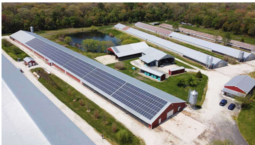
Figur 7-7 - Bilde på solcelleinstallasjon ved en kyllinggård 44 ved østkysten i USA på 114 kW p .
