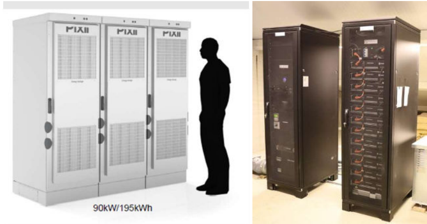
Foto venstre: 195 kWh system fra den norske leverandøren Pixii. Foto høyre: Batterier for lagring av solenergi på Skjerpe gård i Rogaland ( https://www.norgesvel.no/aktuelt/innsikt-i-fremtiden-kan-klimasmarte-grder-g-p-batteri )
