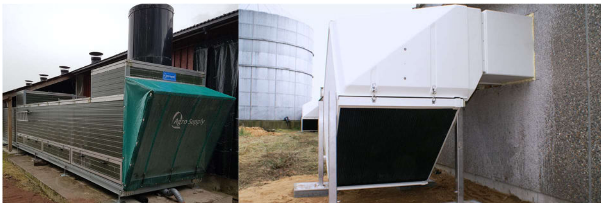
Figur 7-6 - Bilder av varmegjenvinnere installert fra to av de større leverandørene av denne type gjenvinner.
